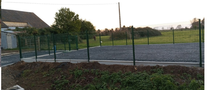
Réserve incendie de « La Vallée »
